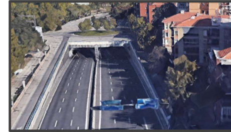
Túnel Av. de Portugal
