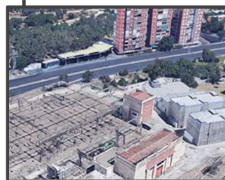
Subestación de Iberdrola
