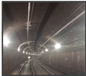
Túnel Metro L-5
