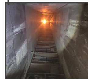
Línea 6 de Metro
